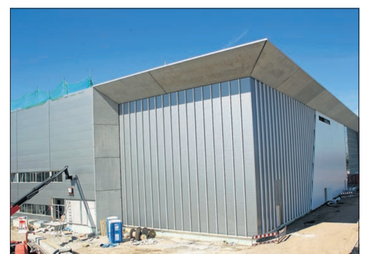
XXXL Fortschritt: Mit dem neuen Freiburger XXXL Möbelhaus entsteht eines der modernsten Einrichtungshäuser Europas. Die Gebäudehülle ist bereits komplett fertig, nun werden die Außenanlagen in der Hermann-Mitsch-Straße in Angriff genommen.
