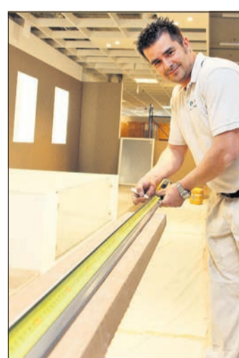
XXXL Endspurt: Im Inneren des neuen Freiburger XXXL Möbelhauses sind die Handwerker aktuell damit beschäftigt, den Innenausbau fertigzustellen.
